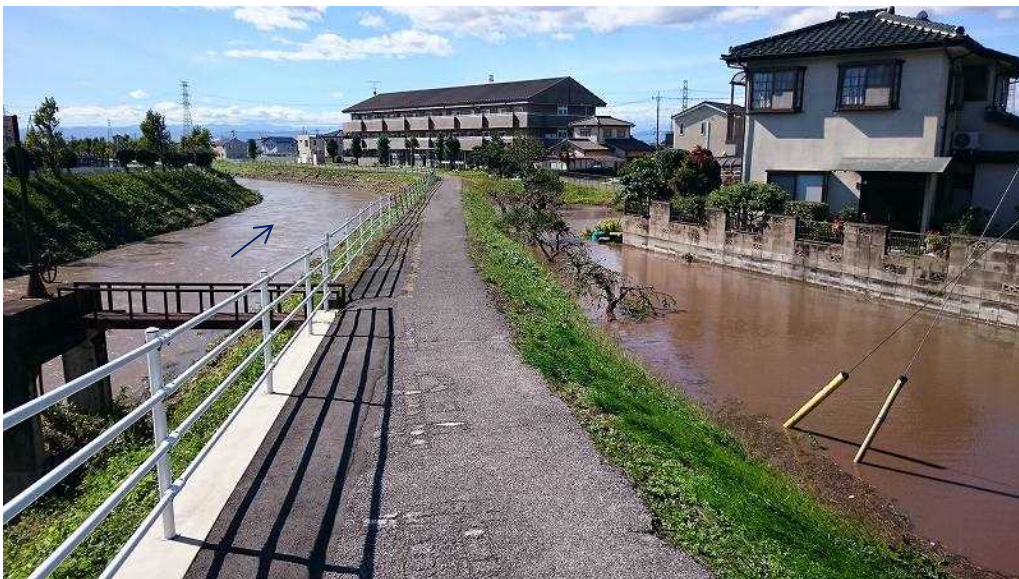
蛇川 出水状況 (太田市)
