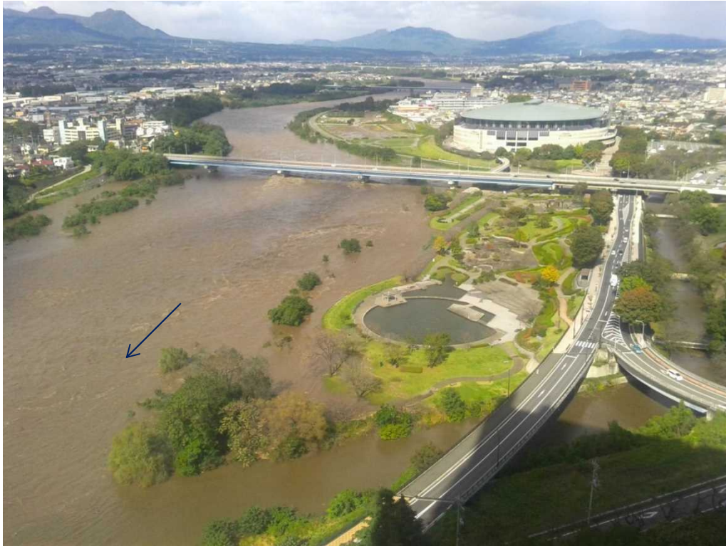
利根川(県庁裏) 出水状況 (前橋市)
