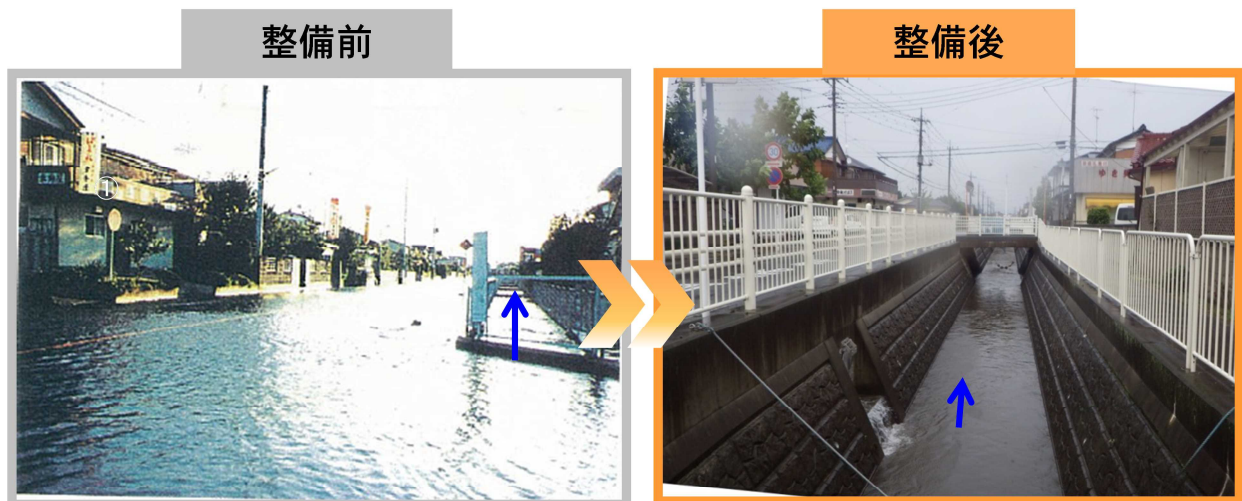
新中野団地内 S57.9月出水状況
